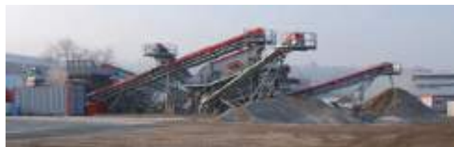
Exemple d'installation fixe
