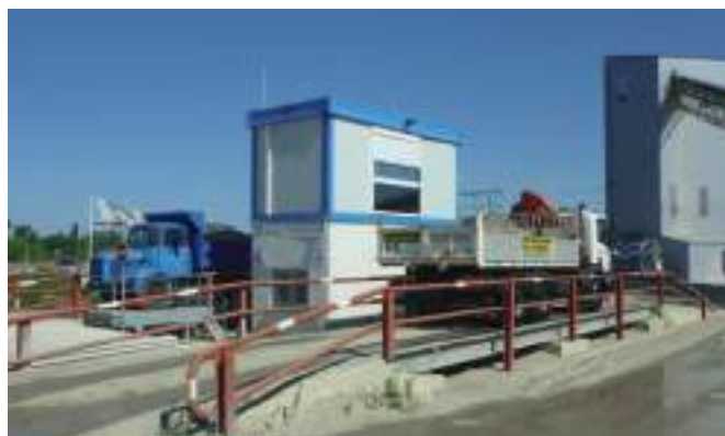
Contrôles visuel et administratif à l'entrée
